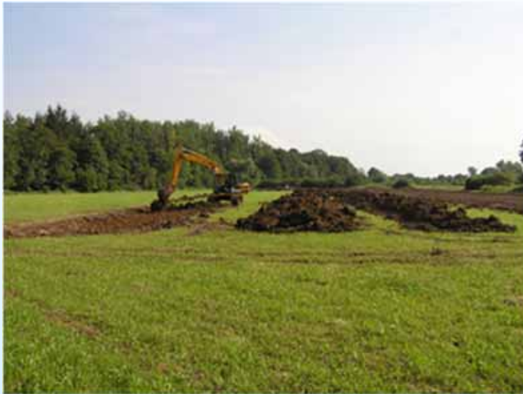
Ausbaggern der 2. Rinne.
