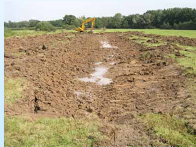
Ausbaggern der ersten von 3 Rinnen.
